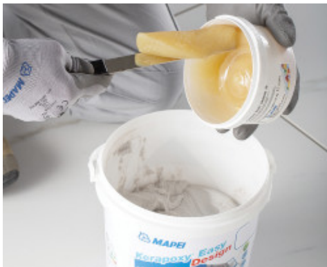
Hæld hærdemidlet (komponent B) i spanden med komponent A
