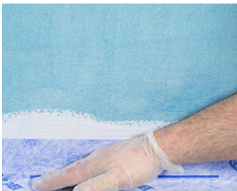
Montering af Mapei ST tætningsbånd ved hjælp af Mapegum WPS på overgangen mellem gulv og væg
