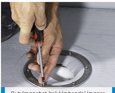
Butylmanchet (selvklæbende) lægges ned over afløbet (på færdigprimet gulv). Derefter påføres Mapegum WPS over manchetten og resten af gulvet
