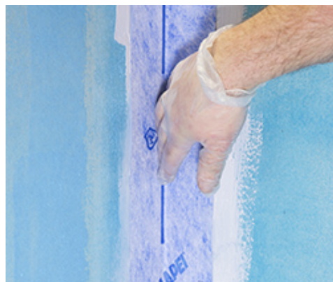
Montering af Mapei ST tætningsbånd ved hjælp af Mapegum WPS på væg
