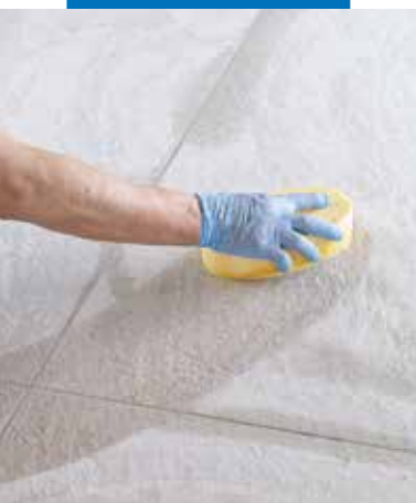
Slutrensning af fuger med hård cellulosesvamp
