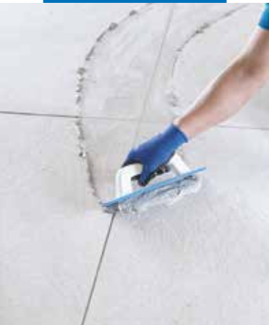
Fugning med Keracolor GG og MAPEI pudsebræt
