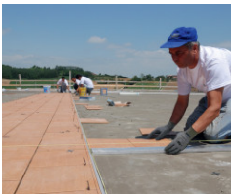
Montering af keramik med Kerabond + Isolastic
