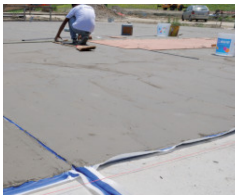
Fugtisolierende afretningslag med Mapelastic og Mapesil
