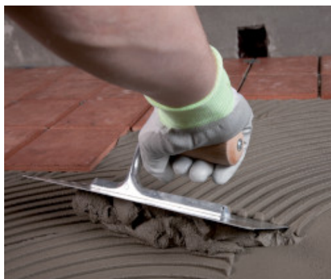
Påføring af Granirapid på terrasse vandtætnet med Mapelastick
