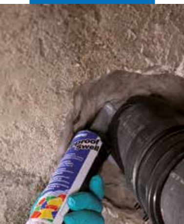
Gennemføring, forseglet med Mapeproof Swell
