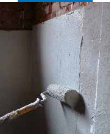
Påføring af Mapelastic Foundation med rulle på underlag, afrettet med Planitop HDM Maxi
