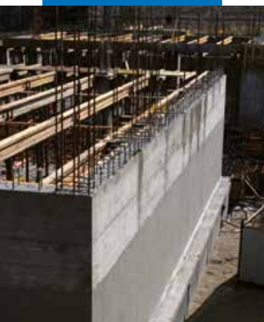
Støttemur, tætnet med Mapelastic Foundation efter støbning
