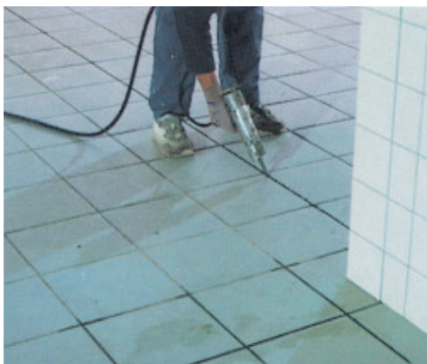
Forsegling af keramiske fliser med Mapesil AC
