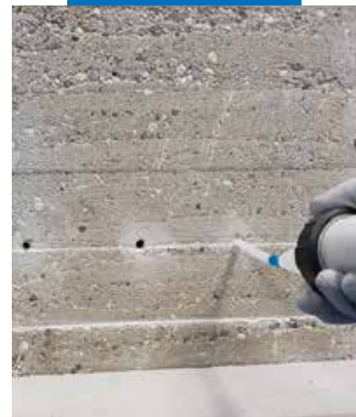
Skab en kemisk barriere i en betonvæg
