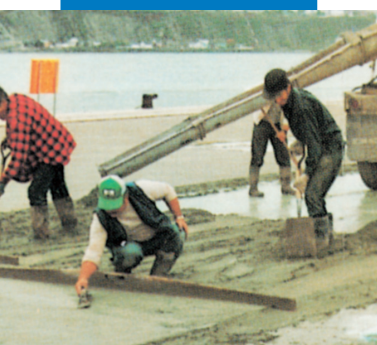
Udvendig, cementholdig afretning med Planicrete - Vieux Port, Quebec, Canada
