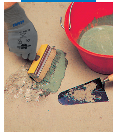
Gulvpreparation: Påføring af slemmemasse
