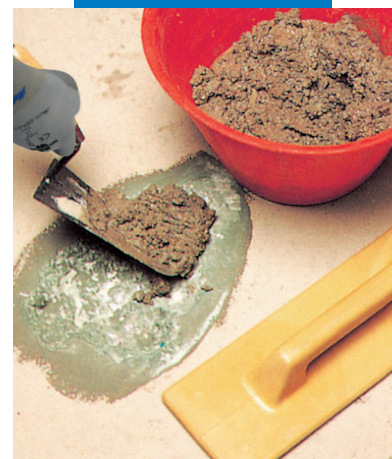
Gulvpreparation: Påføring af mørtel
