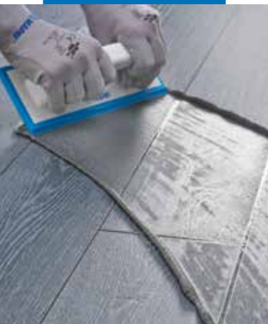
Fordeling af Ultracolor Plus på gulv med gummispartel
